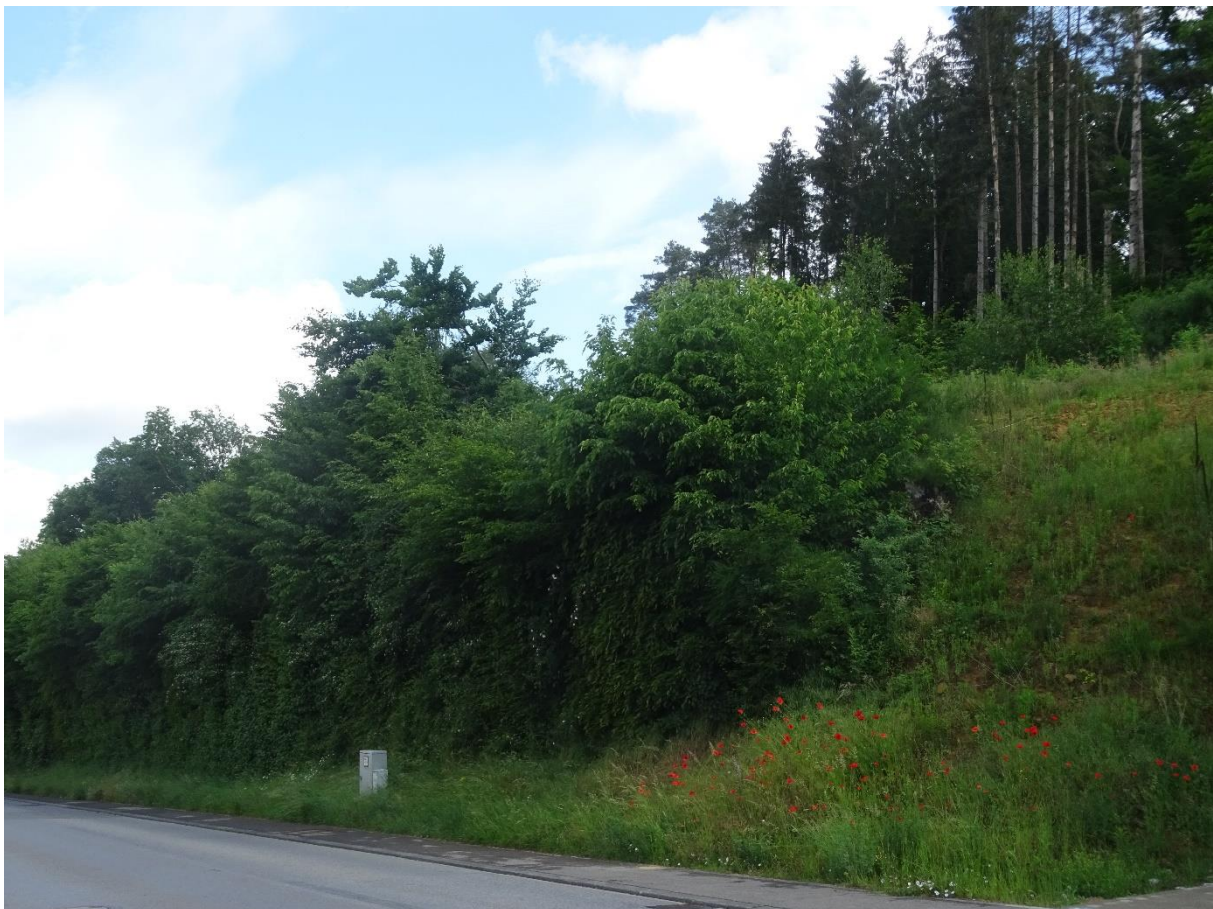
Abb. 6: Blick auf den südlichen Bereich von Ho_30, Quelle: zilmplän s.à r.l., Juni 2018
