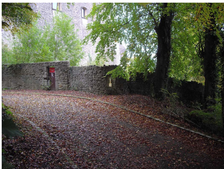
Se. 23 : Mur sec Septfontaines
