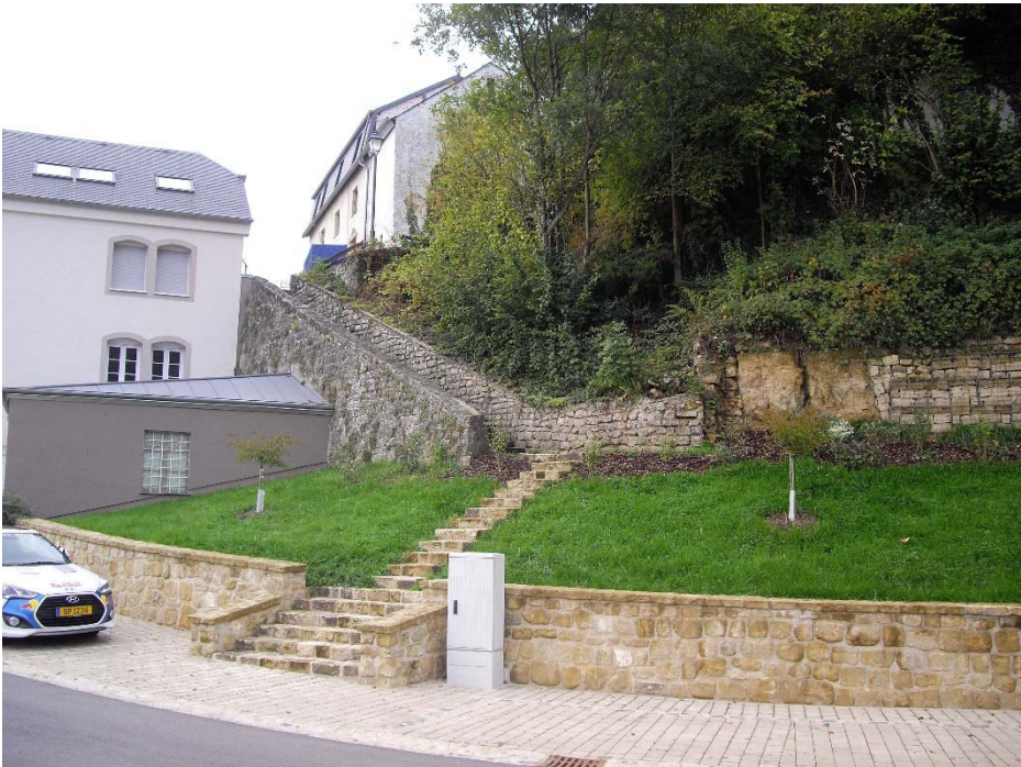
Se. 27 : Mur sec Septfontaines
