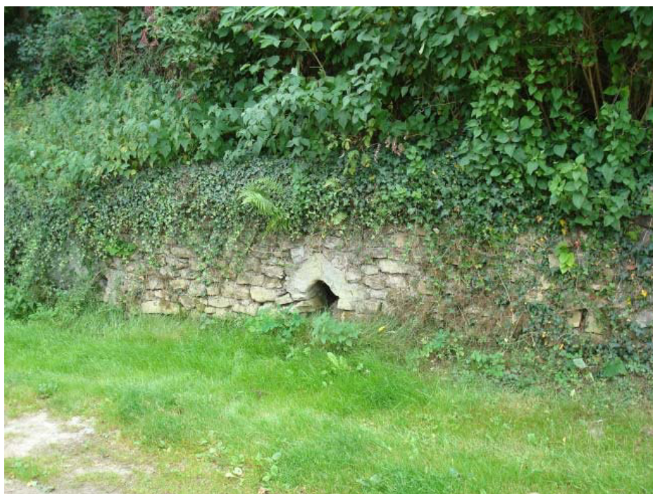
Ro. 18 : Mur sec Roodt
