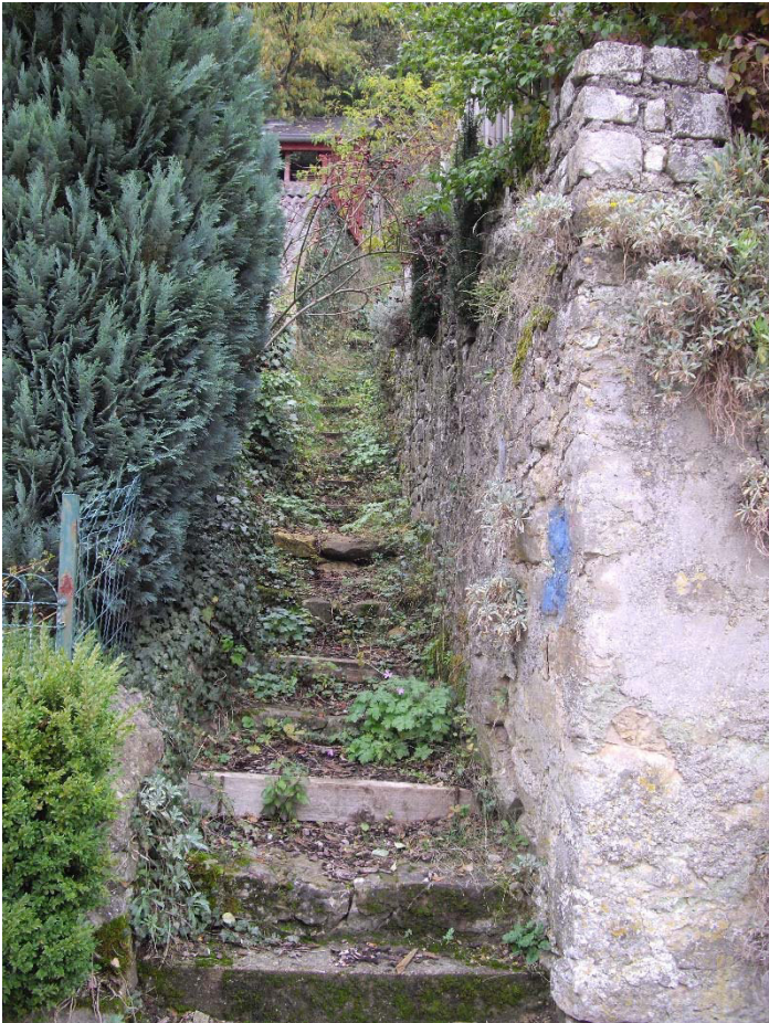
Se. 26 : Mur sec Septfontaines
