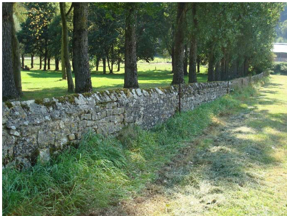
Se. 1 : Mur sec Septfontaines
