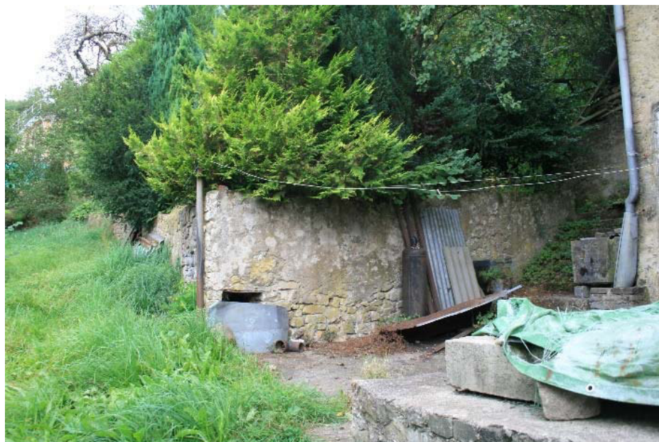
Se. 14 : Mur sec Septfontaines
