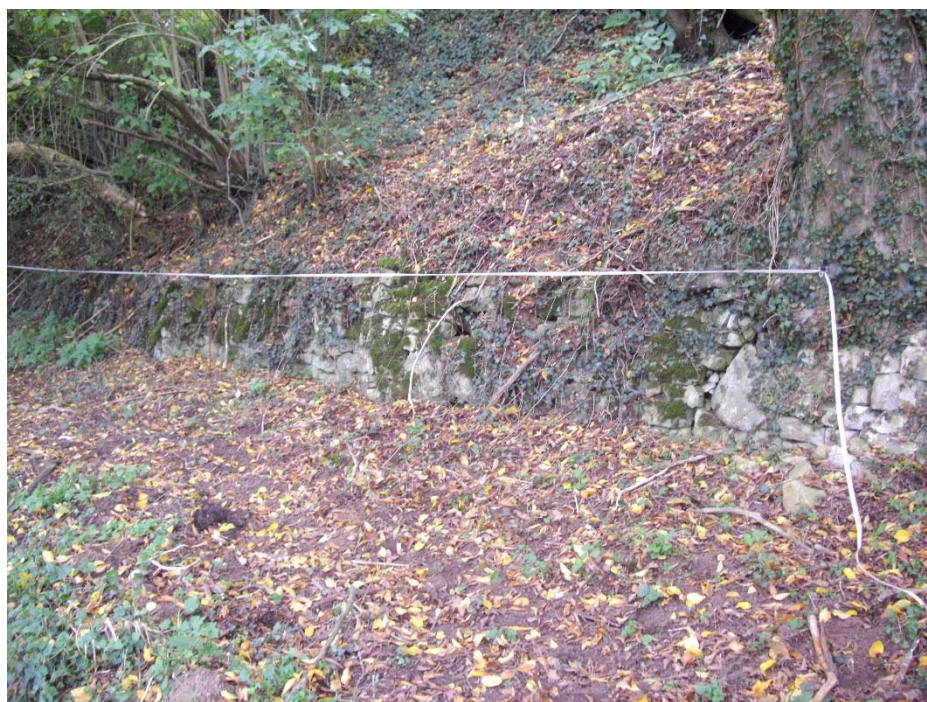
Se. 40 : Mur sec Septfontaines
