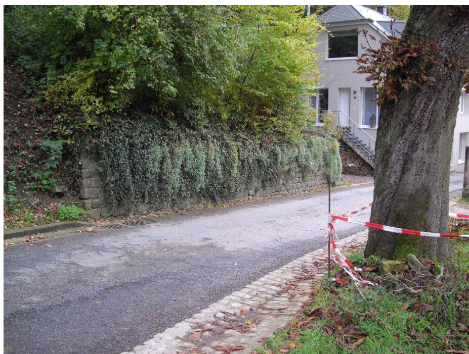
Se. 17 : Mur sec Septfontaines
