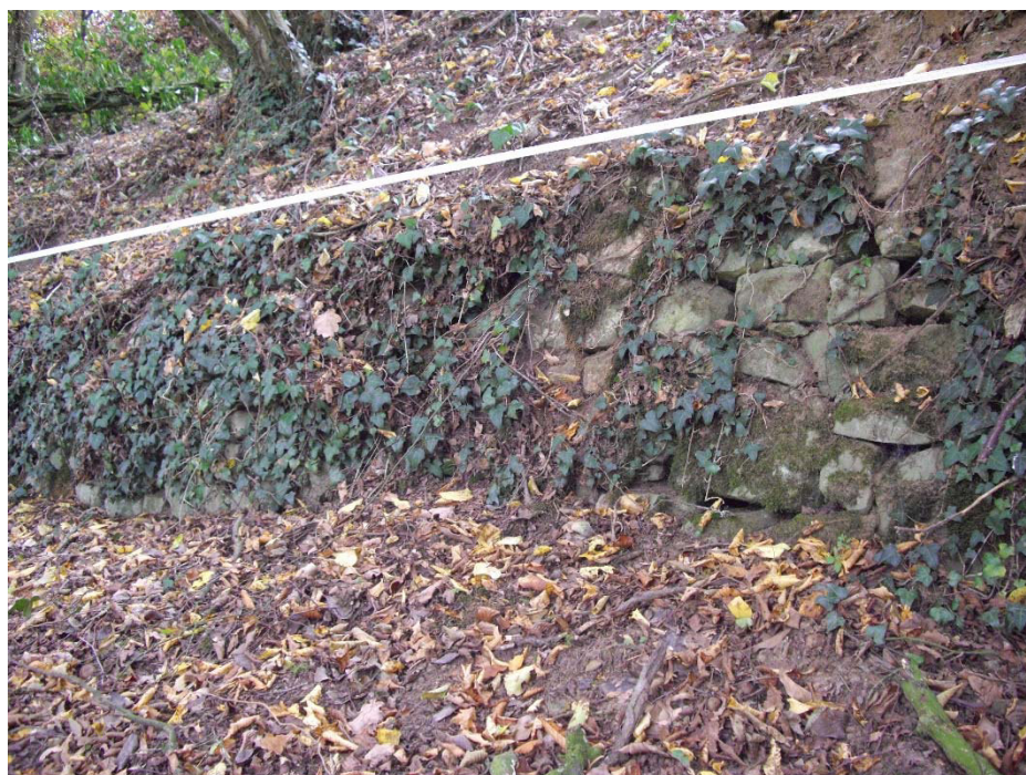
Se. 41 : Mur sec Septfontaines
