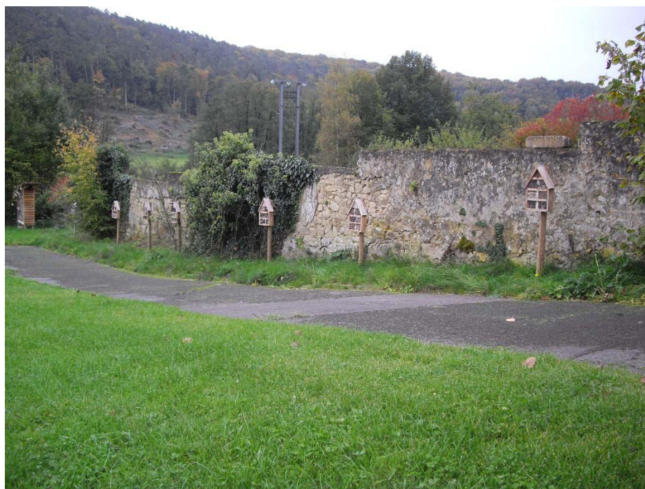
Se. 34 : Mur sec Septfontaines
