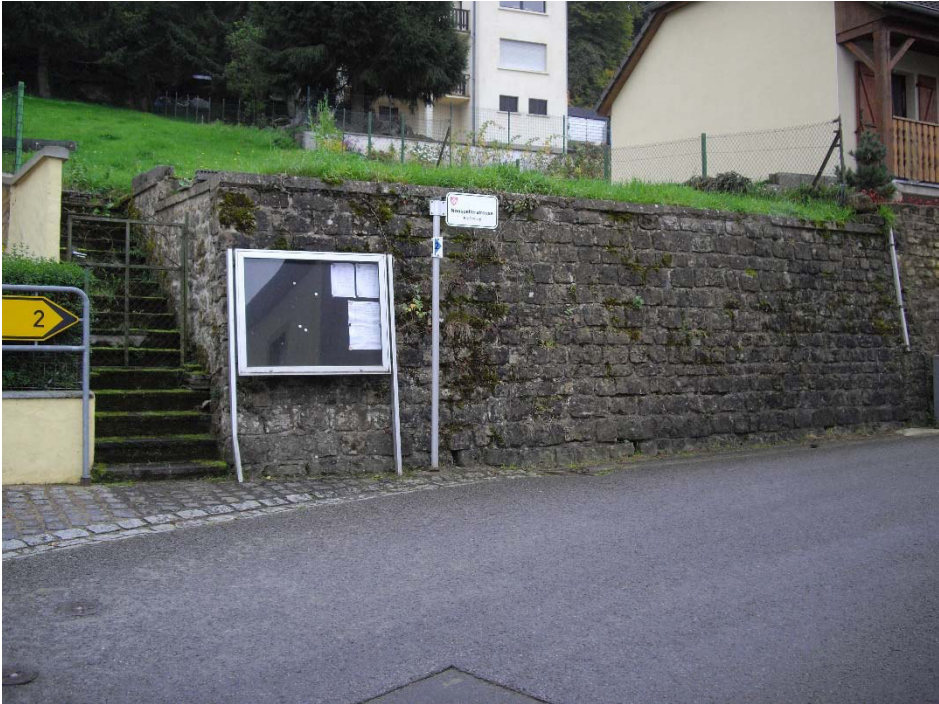
Ro. 24 : Mur sec Roodt
