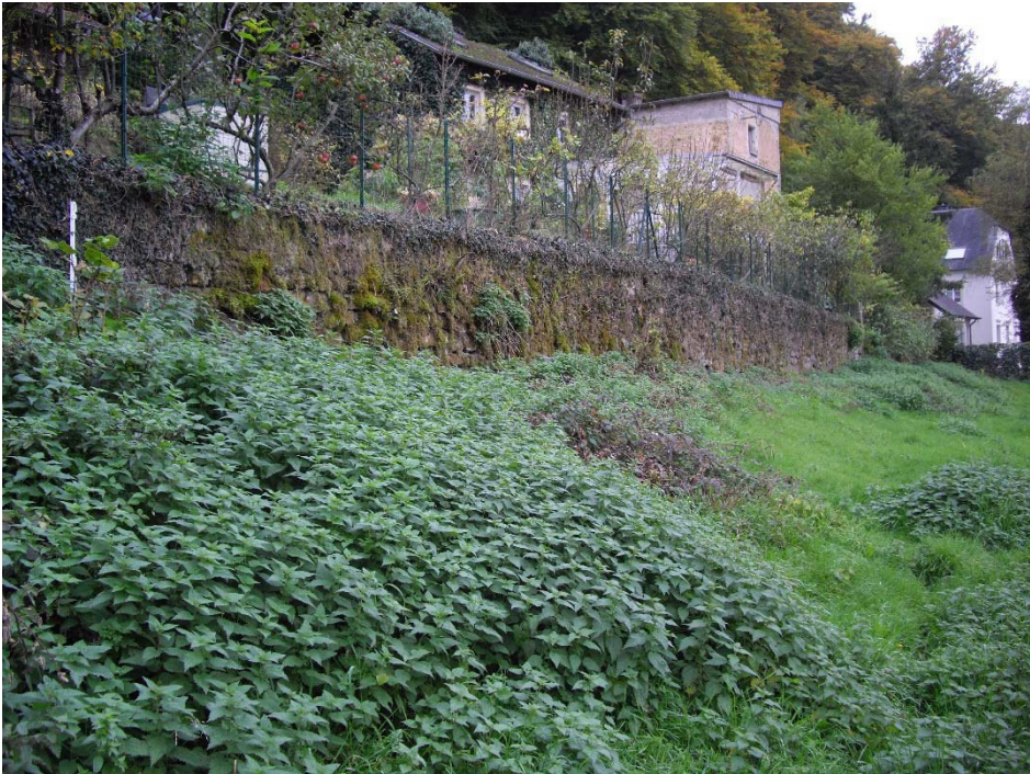
Ro. 23 : Mur sec Roodt
