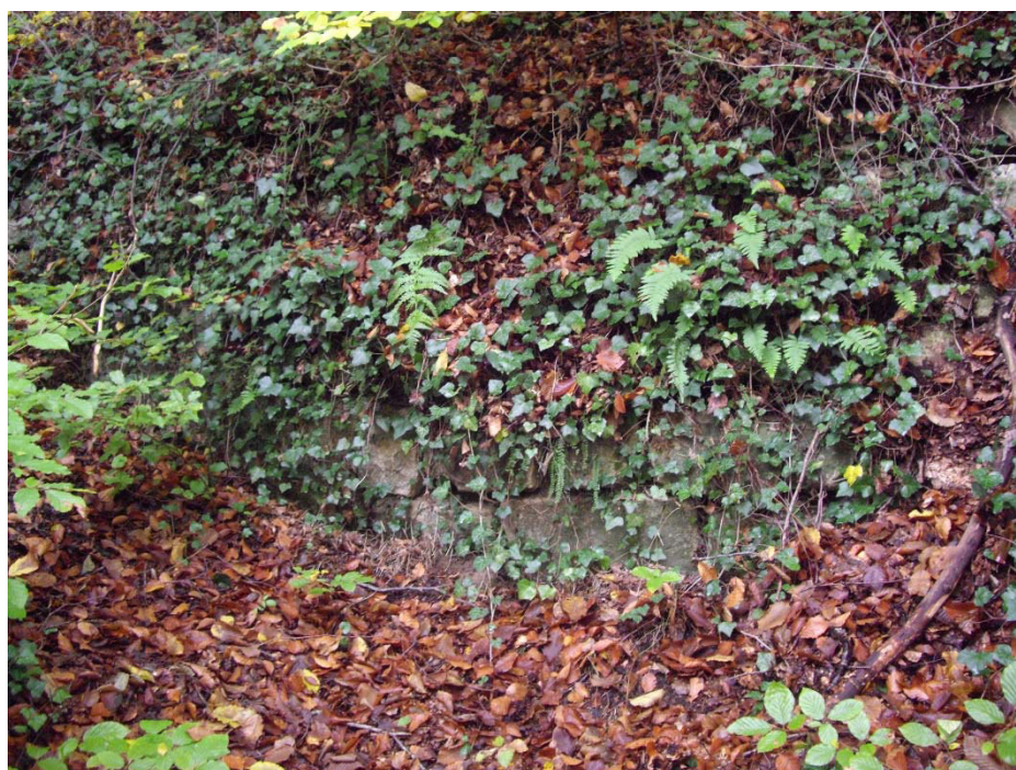
Se. 25 : Mur sec Septfontaines
