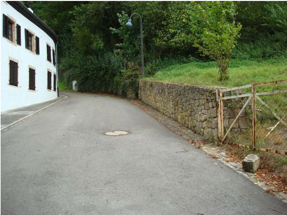
Ro. 16 : Mur sec Roodt
