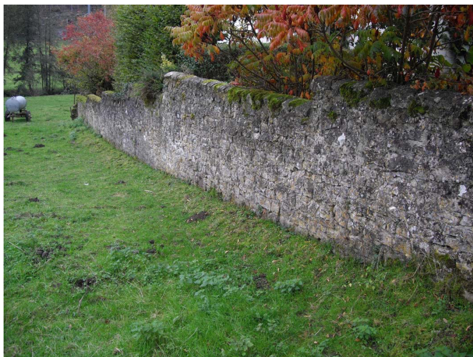
Se. 33 : Mur sec Septfontaines
