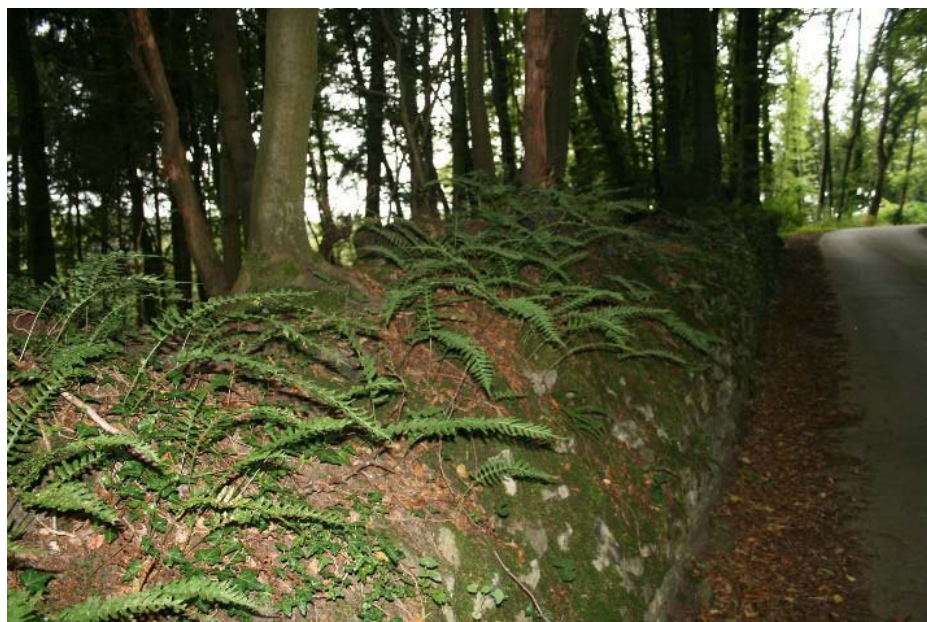
Se. 15 : Mur sec Septfontaines
