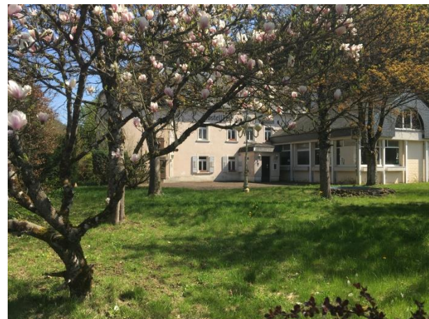
Abb. 42: Bestehende Bebauung auf Ss_02, Quelle: eigene Aufnahme
